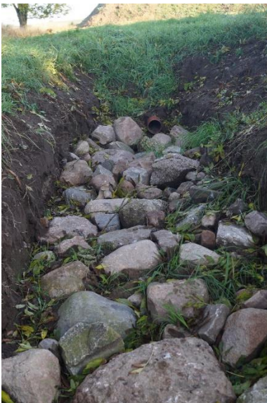
Fig. 6. Eksempel på hhv. iltningsrende og iltningsbrønd
