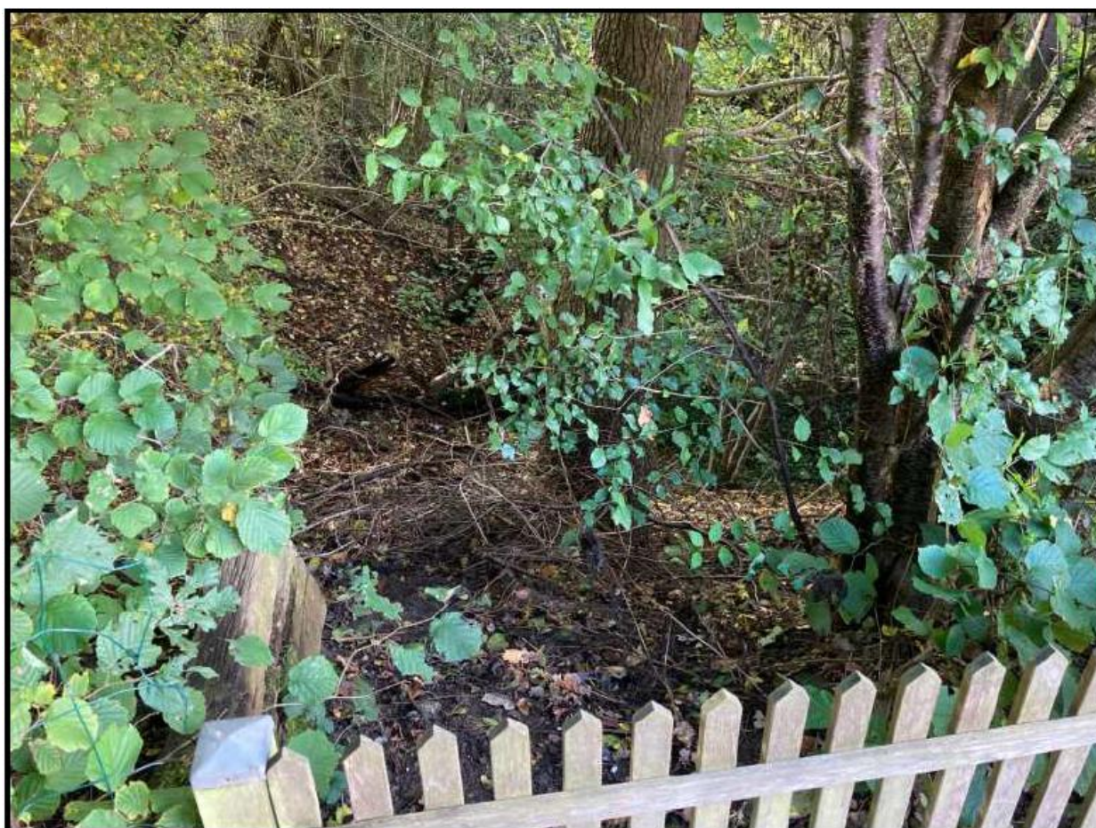
Foto 3. Duedalen 30-32, Mergelhul/lavning ved skel d. 12.10.2020.
