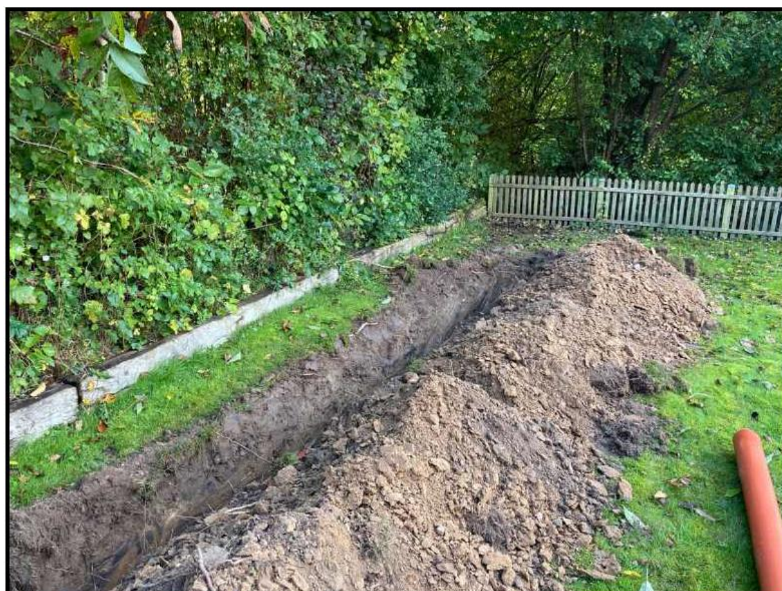
Foto 2. Duedalen 30-32, placering af rørledning frem til skel ved lavning d. 12.10.2020.
