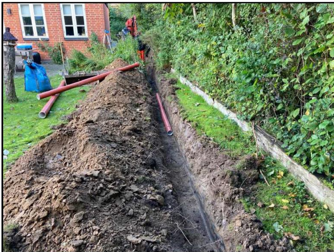
Foto 1. Duedalen 30-32, placering af rørledning langs gavlen d. 12.10.2020.
