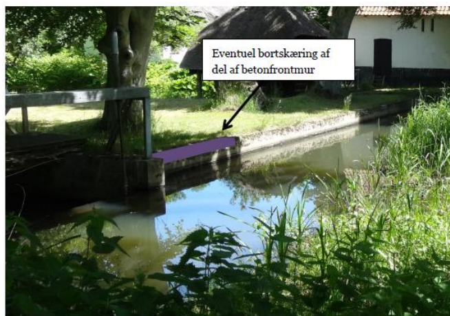
Figur 3: Bortskæring af del af frontmur i den nordlige del af møllesøen ved stemmeværk.
