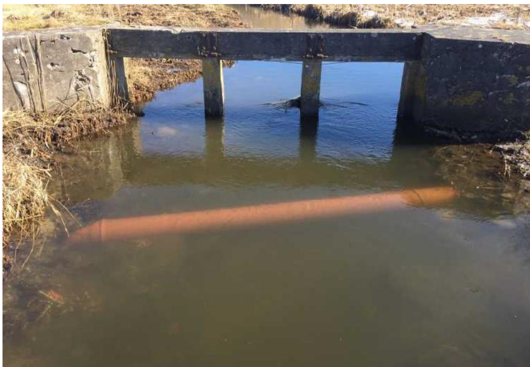
Foto 1. Eksisterende hovedledning over vandløbsbunden
