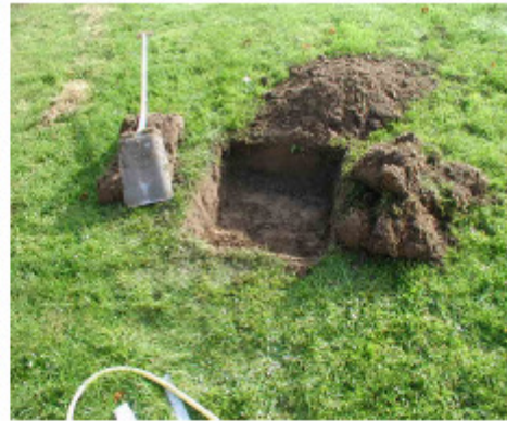
Der udgraves mindst 2 prøvehuller ned til det niveau, hvor faskinen skal ligge. Selve prøvehullet skal være min. 0,25 m x 0,25 m og mindst 0,3 m dybt. Hullerne skal ligge mindst 5 m fra hinanden.
