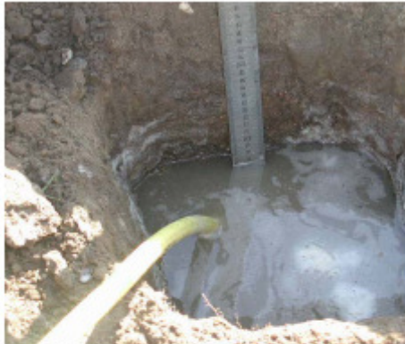
Synkehastighed måles. Hvis vandspejlet synker lige meget ved 2 målinger på fx 2 min. efter hinanden kan infiltrationstesten begynde.
